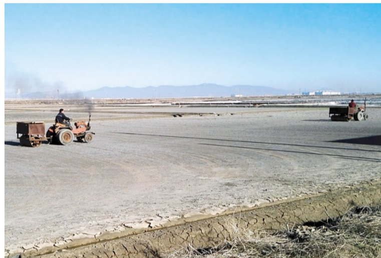
日前，徐圩投资公司紧抓连续晴好天时，迅速推进池板晾晒工作，及时出动13台压路机，明确限期包片责任，加大现场安全工作指导力度，加班加点抢压池板910块、31500亩，为全面开展春晒制卤工作奠定基础。(徐宣方洋)
